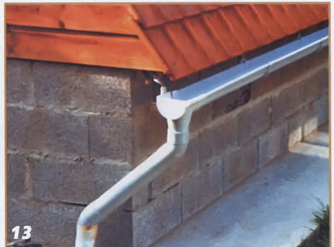
13 Водослив воды с крыши осуществляется через канализационную трубу Ø100 мм, проложенную через бетонную отмостку.
