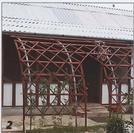
2 Каркас навеса уже покрашен, но ещё без крыши. Вдоль навеса высажены кусты дикого винограда.
