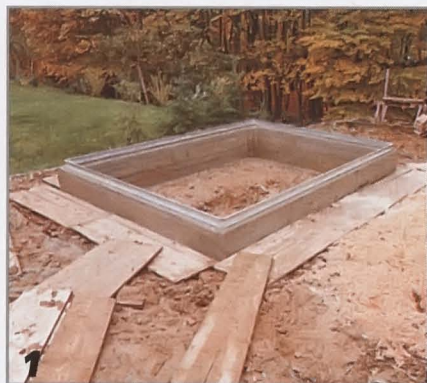
1 Ввиду того, что земельный участок имеет уклон, под теплицу возводят бетонный фундамент.
