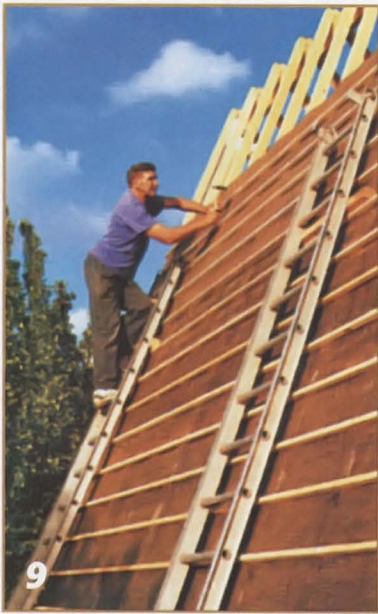
9 После укладки слоя паровлагозащиты (пергамин) к стропилам пришивают бруски обрешётки с шагом, обеспечивающим укладку черепицы.
