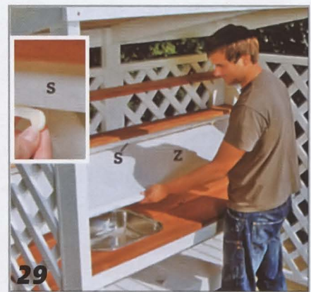
29 Планку-шторкодержатель S крепят на расстоянии 30 мм от планки Т. Шторка Z в свернутом положении удерживается поворотной щеколдой.
