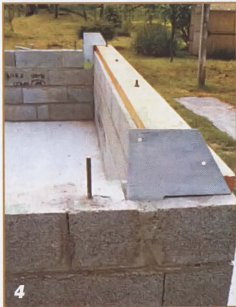
4 Доски нижней обвязки крепят к цоколю с помощью анкеров. Стальные пластины служат для крепления крайних стропил.
