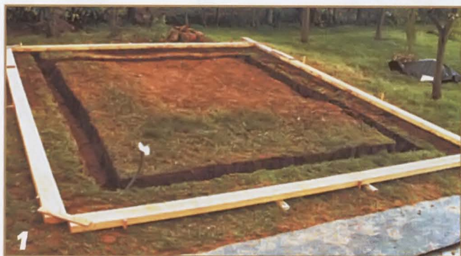
Для заливки фундаментной плиты по периметру выкапывают траншею 0,3x0,5 м — будущий пояс жёсткости.
