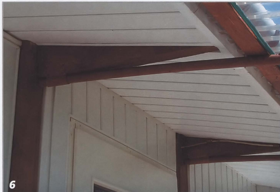
При помощи хомутов, сделанных из кровельного железа, дуги каркаса арочного навеса прикреплены к свесу крыши. Листы прозрачного поликарбоната одним концом подсунуты под сливной желоб на крыше дома, а другой конец листов прикреплен к деревянным рейкам каркаса навеса шурупами.
