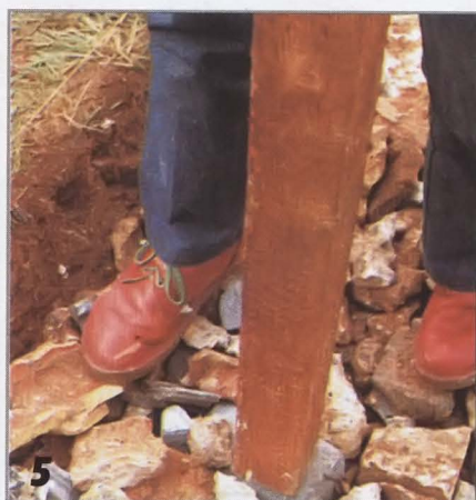
Отсыпанный щебень тщательно уплотняют самодельной трамбовкой с ручкой-поперечиной в верхней части.
