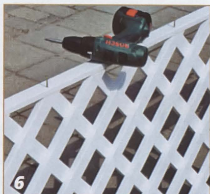
Решётки скрепляют со стойками А, В и С.
