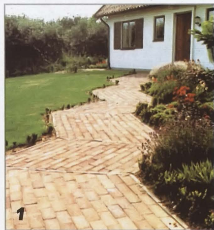
Оригинальна зигзагообразная дорожка с поперечными «разделительными линиями», несмотря на то, что она выложена из простых по форме камней.
