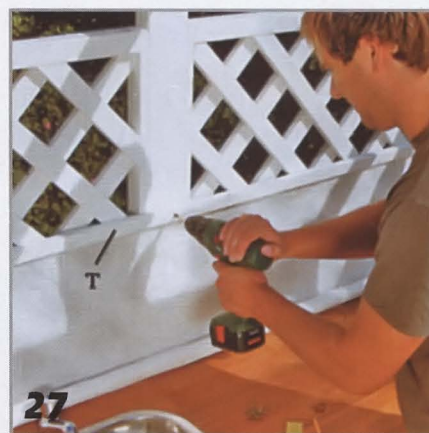
27 Планку Т с закреплённой тканью привинчивают к задним стойкам С.
