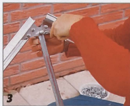
3 Соединяют торцовый элемент с раскосами и средней связью для остекления.
