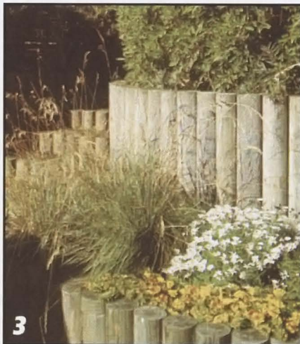
Из деревянных кольев сооружают не только лестницы, но и подпорные стенки.
