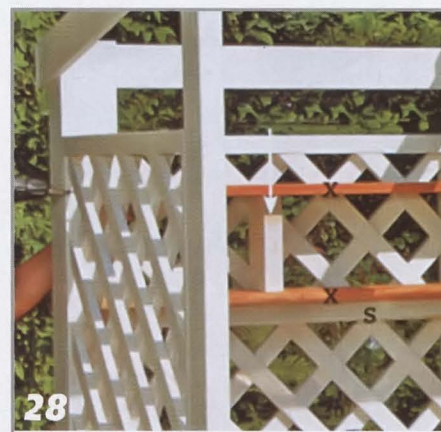
28 Доски полок X фиксируют шурупами Ø5x60 мм. Между полками размещают опоры-проставки длиной 170 мм.
