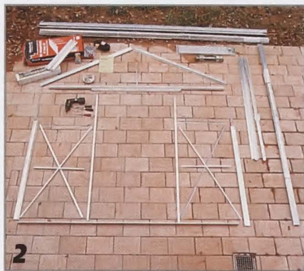
2 На ровной площадке раскладывают элементы передней стенки теплицы.
