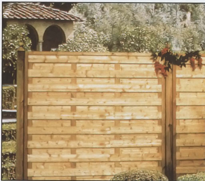
Эти заборы — ветровые экраны — сделаны в виде отдельных секций 1,8x1,8 м с двусторонней обшивкой тонкими досками или полосами влагостойкой фанеры.
