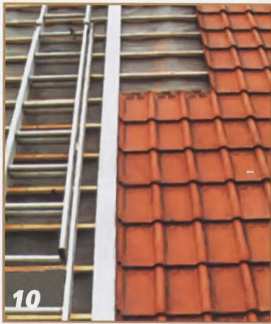
9 После укладки слоя паровлагозащиты (пергамин) к стропилам пришивают бруски обрешётки с шагом, обеспечивающим укладку черепицы.
