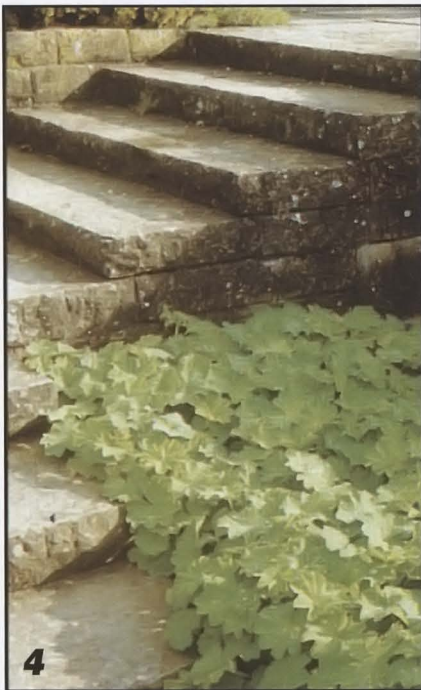
Ступени из бетонных или каменных плит очень удобны, однако требуют предварительного возведения морозостойкого фундамента.
