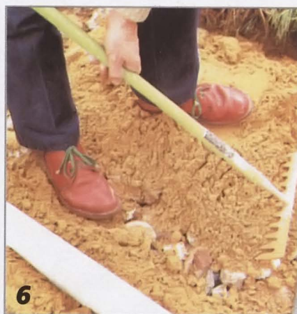
Прежде чем трамбовать песок, укладывают бордюрные камни. Если грунт в саду рыхлый, их лучше посадить в бетон.
