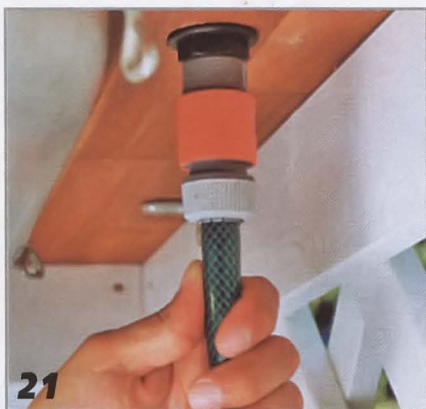
21 Используя поливочный шланг, мойку подключают к водопроводу.
