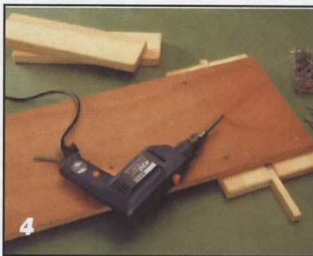
4 Сосновые доски вставной полки крепят снизу к фанере толщиной 18 мм шурупами для ДСП (по 4 шт. на каждую доску). На краях предварительно снимают фаски.
