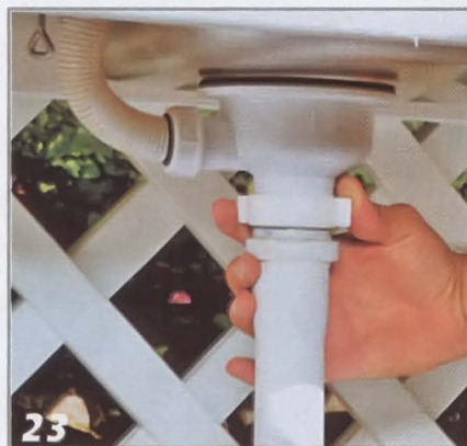
23 Остаётся проверить герметичность соединений сифона мойки, и можно подключать воду.
