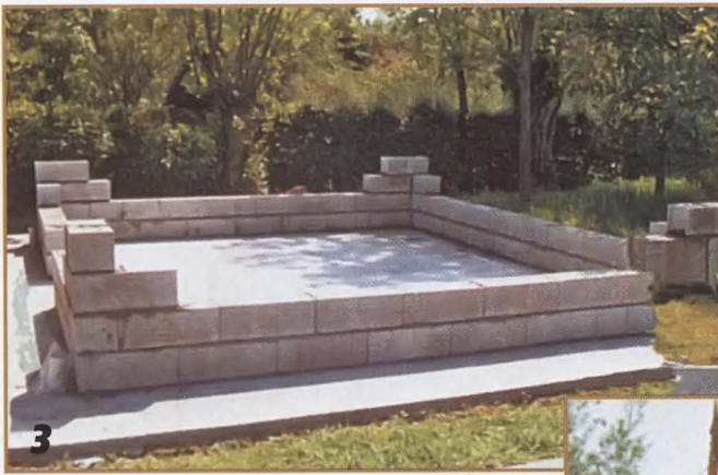
3 Цоколь (высотой 0,8 м) домика выкладывают из цементно-бетонных блоков 20х30х60 см.
