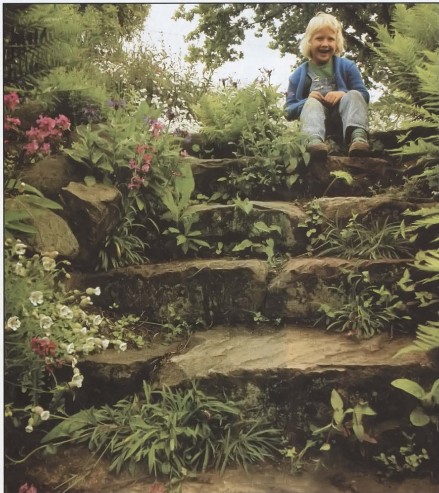
Ступени из бетонных или каменных плит очень удобны, однако требуют предварительного возведения морозостойкого фундамента.
