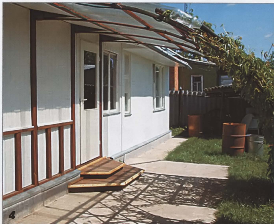
4 Так дуги навеса крепятся к свесу крыши дома хомутами из кровельного железа. Проемы веранды пока закрыты специальными щитами, которые я снимаю весной и устанавливаю обратно поздней осенью при подготовке дома к зиме.
