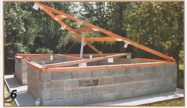
6 Две треугольные фермы собирают на цоколе и поднимают по-очереди, упирая стропильные ноги в металлические крепёжные элементы.
