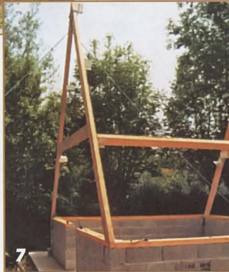
6 Две треугольные фермы собирают на цоколе и поднимают по-очереди, упирая стропильные ноги в металлические крепёжные элементы.
