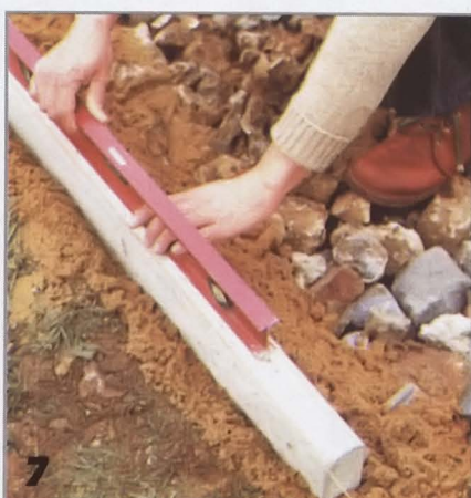
Песок тщательно разравнивают, проверяя, действительно ли под камнями будет ровное основание.
