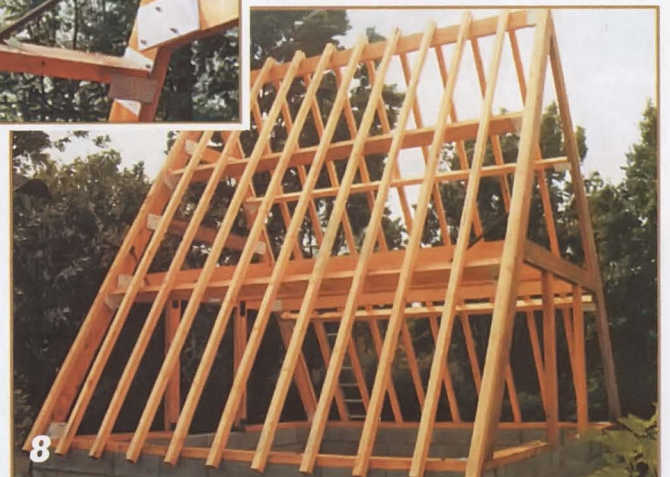
8 Стропильная конструкция выполнена из длинных брусьев.
