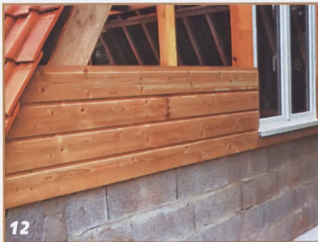
12 С наружной стороны стены домика обшиты горизонтальными досками-вагонкой.
