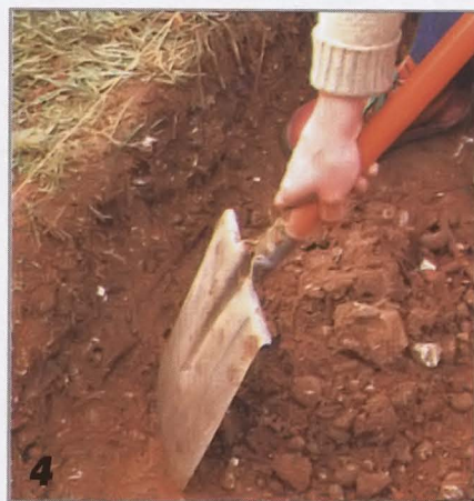
Грунт снимают на глубину порядка 25 см. Ровно ли основание, проверяют с помощью уровня и рейки-правила.
